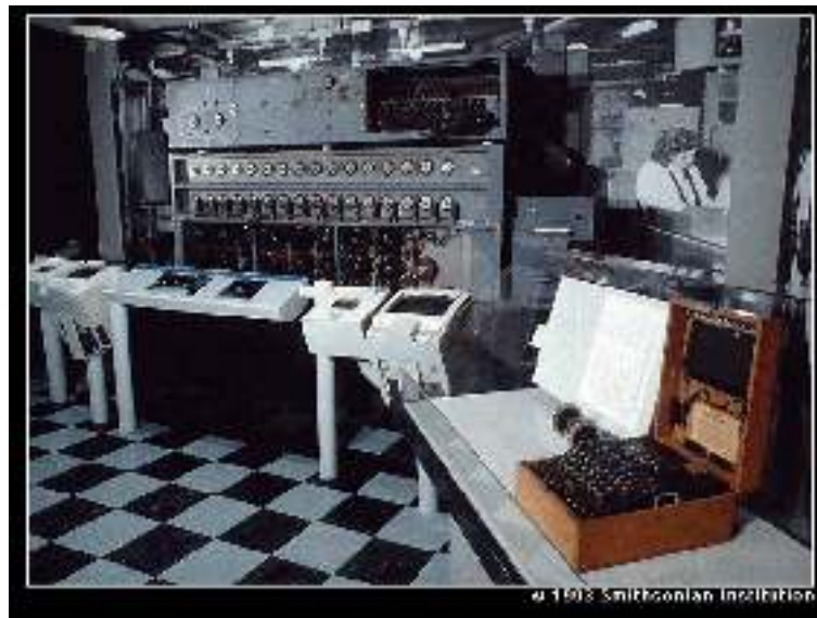
Abbildung 2.9: Eine Enigma und eine Bombe.
